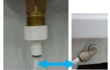
3. Откройте запорный кран холодной воды. При обнаружении следов утечки в зоне соединения шланга закройте запорный кран и проверьте все части соединения. Устраните утечку. Убедитесь, что подаваемая вода не течет ни внутри и ни снаружи. Откройте запорный кран холодной воды.
